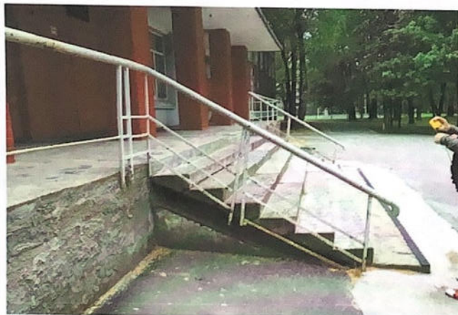
Рис.11 Входной узел на объект
