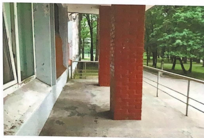
Рис.12 Входной узел на объект : площадка с колоннами перед входной дверью
